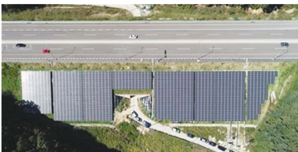
국도 6호선 강원 횡성읍 읍상리 성토부에 설치된 태양광 시설. /국토교통부 제공
